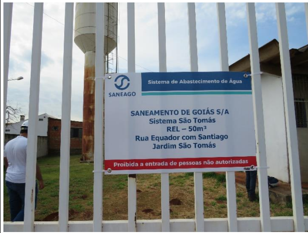
Autor: AMAE/RIO VERDE Descrição: Ausência de informação sobre o volume de 100 m 3 do RAP na placa de identificação.
