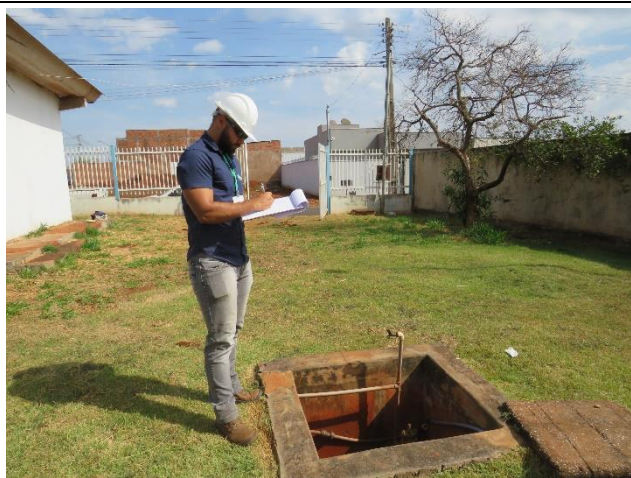
Autor: AMAE/RIO VERDE Descrição: Caracterização do sistema de reservação São Tomaz pela equipe de fiscalização AMAE Rio Verde.
